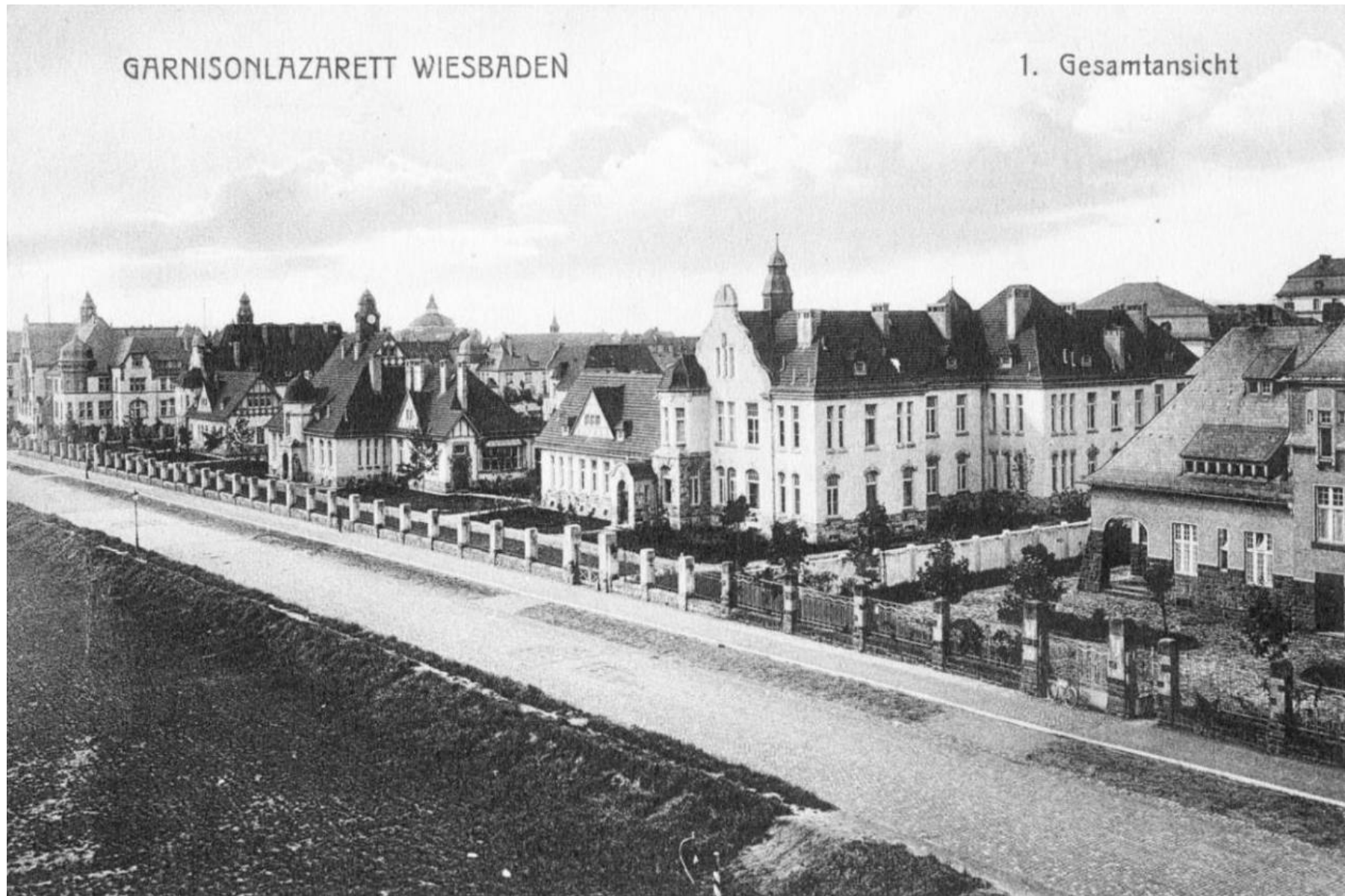
Die medizinische Abteilung im heutigen Gebäude A (damals Krankenblockgebäude). Im rechten Bildrand die Garnisonswaschanstalt. Das Waschhaus selbst stand auch auf dem Waschplatz.
